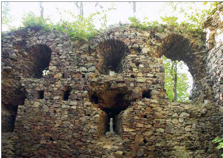
Obr. 76: Nový Herštejn, k. ú. Němčice u Kdyně, okres Domažlice. Okenní otvory a střílny přízemí a patra obytné věže, úroveň výškového členění ukazují kapsy pro trámy. Foto P. Sokol 2010.
