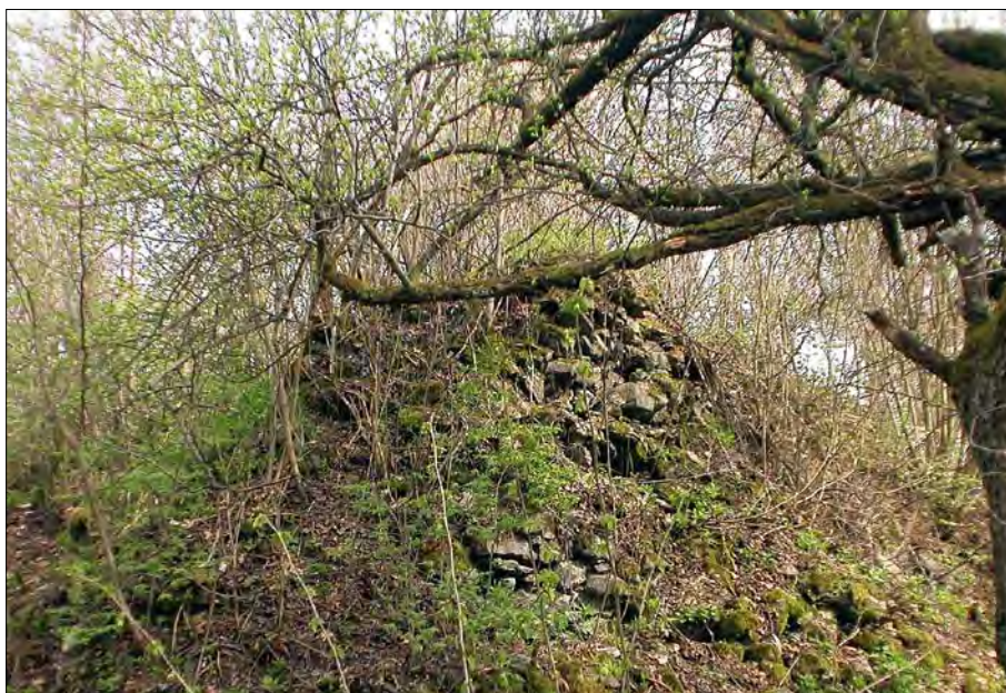
Obr. 81: Krasíkov, k. ú. Kokašice, okres Tachov. Zdivo ve značném stupni eroze, způsobené vegetací a degradací pojiva. Foto P. Sokol 2006.
