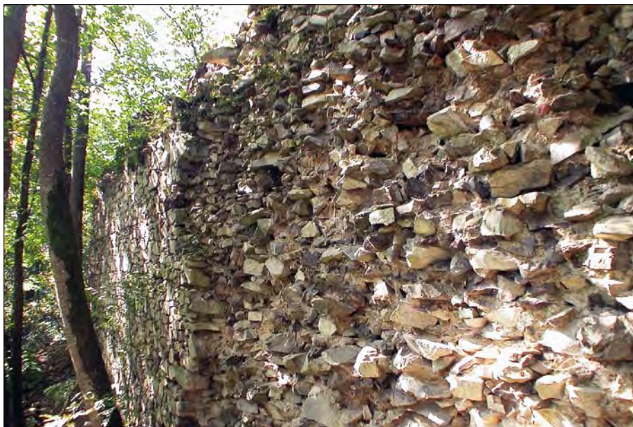
Obr. 80: Nový Herštejn, k. ú. Němčice u Kdyně, okres Domažlice. Eroze líce hradby, jejímž důsledkem bude urychlený rozpad jádra zdi. V tomto případě do osudu hradní zříceniny vstupuje existence přírodní rezervace, kvůli které nebyly povoleny opravy zdiva. Foto P. Sokol 2010.
