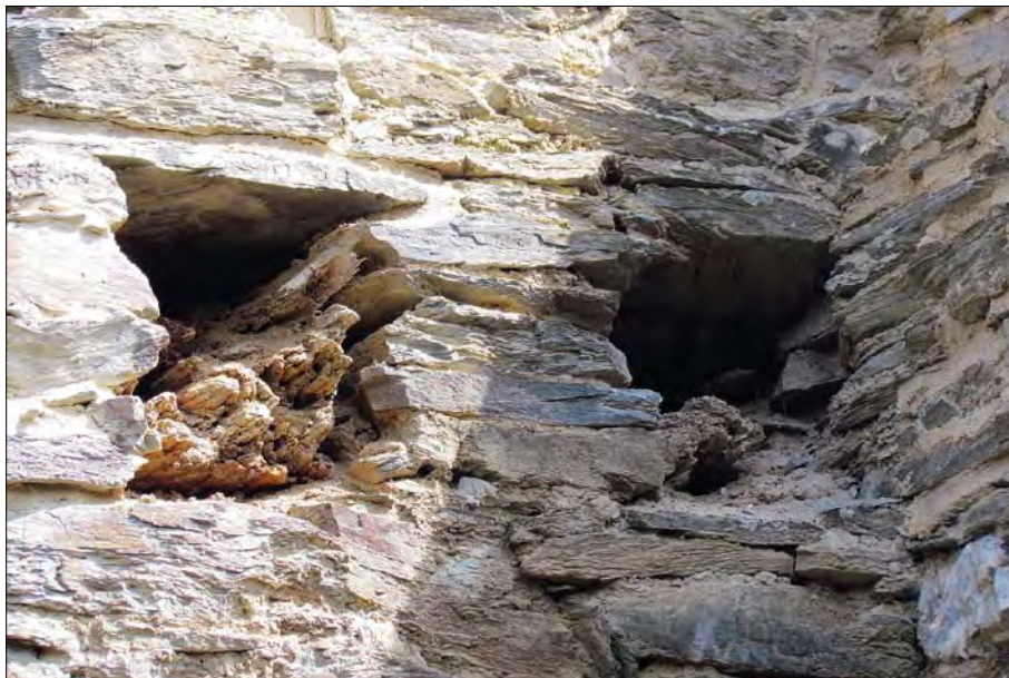
Obr. 78: Gutštejn, k. ú. Okrouhlé Hradiště, okres Tachov. Trámové kapsy, v jednom případě s dochovanou částí podlahového/stropního trámu. Foto P. Sokol 2012.
