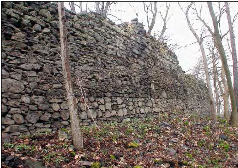
Obr. 74: Preitenstein, k. ú. Nové Městečko u Nečtin, okres Plzeň-sever. Obvodová hradba s patrným postupem zdění, projevujícím se kromě vyrovnávacích spár i barevným odstínem dotyčných úrovní zdi. Foto P. Sokol 2005.
